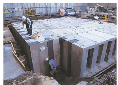
民間工事：静岡県藤枝市
