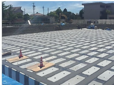
安城市役所：二本木小学校
