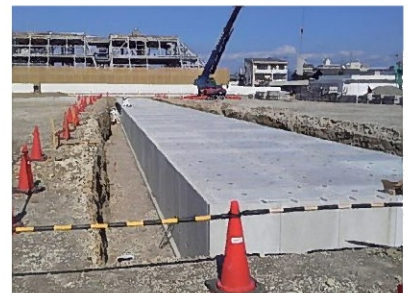
民間工事：岐阜県北方町
