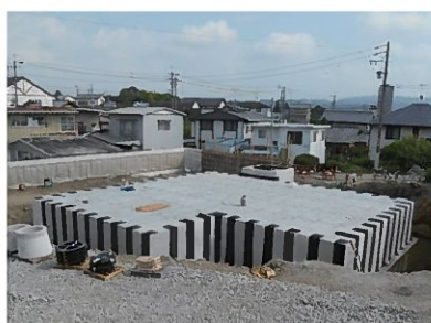
掛川市役所：中央消防署
